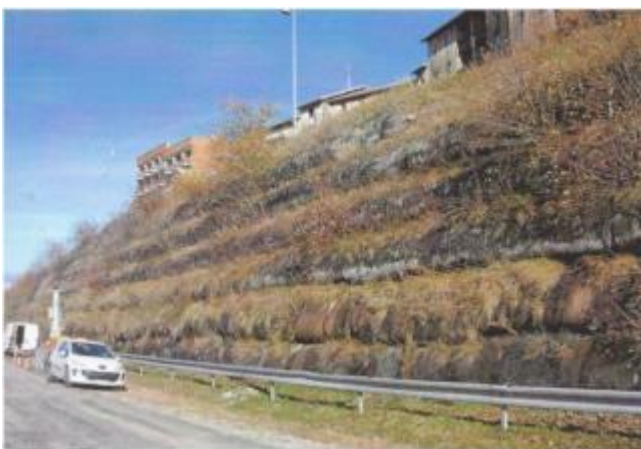
Figure 18. Vue du parement de Prapoutel en 2009: premiers dommages apparents.
