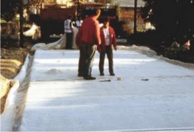
Figure 54. Trois Luc à La Valentine, vue de l'installation du géotextile (1991).
