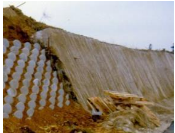
Figure 39. Vue d'un mur de soutènement en sable micro-renforcé à l'arrière-plan d'un mur cellulaire.
