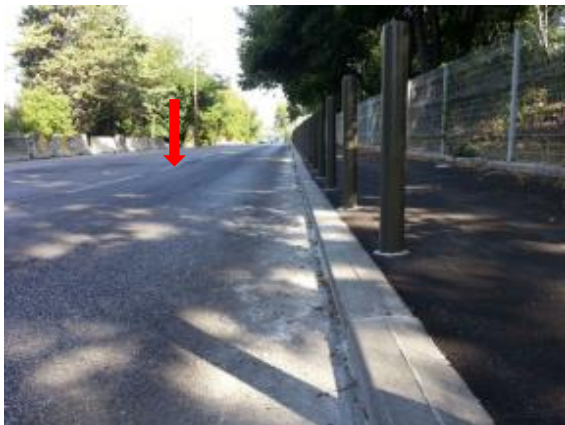
Figure 56. Trois Luc à La Valentine : zone renforcée par géotextile, affaissée en 2015.
