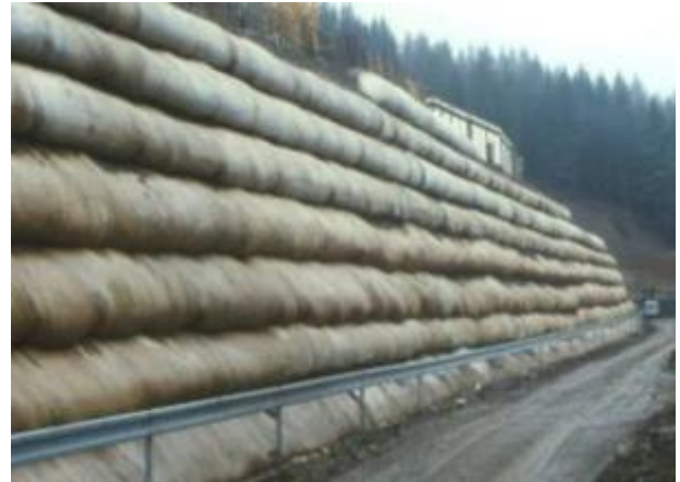
Figure 16. Vue du parement du remblai renforcé de Prapoutel, juste après construction en 1982.
