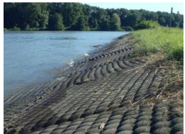
Figure 68. Canal de Jonage : vue du matelas géosynthétique-béton en 2016.
