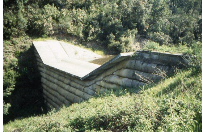
Figure 10. Vue du parement aval du barrage de Maraval en 2015.
