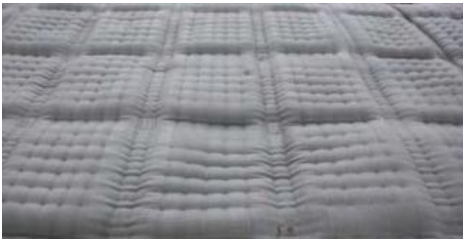
Figure 65. Panneau spécifique, flexible, pour empêcher l'érosion latérale sous le matelas standard.
