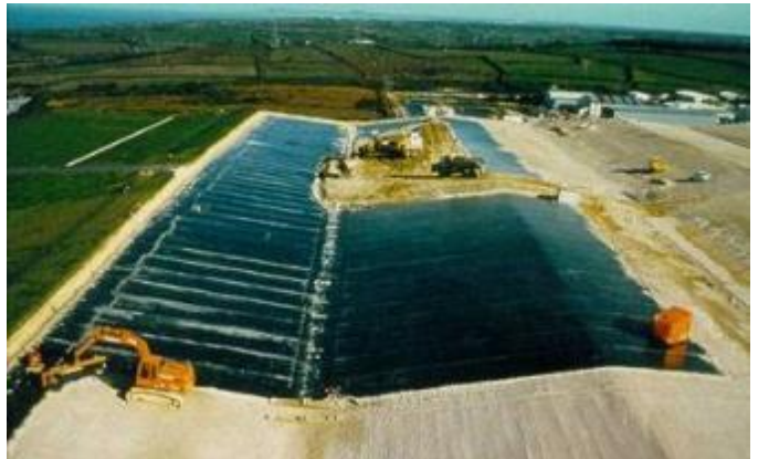
Figure 84. CSM de La Hague ; mise en place de la géomembrane bitumineuse (1991).
