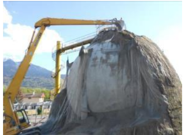
Figure 49. Frontenex : démantèlement du tumulus en sable micro-renforcé en 2016
