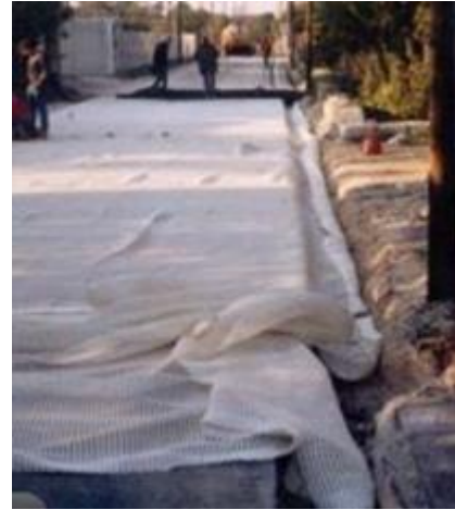
Figure 55. Trois Luc à La Valentine, vue de l'installation du géotextile (1991).
