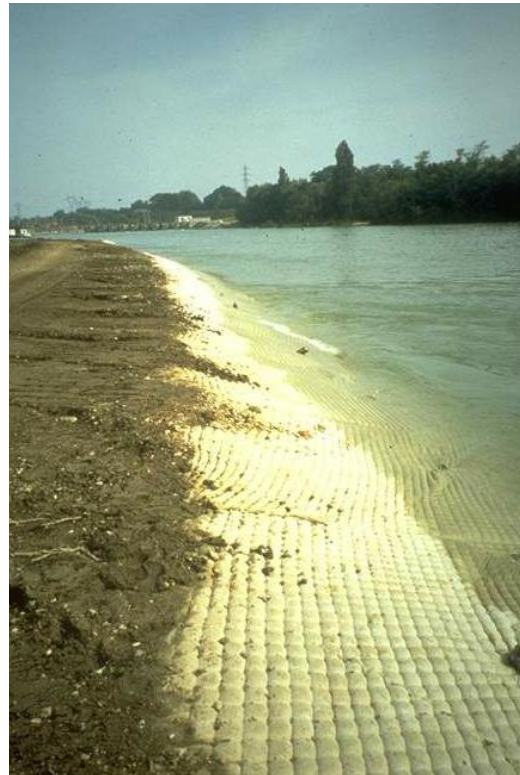
Figure 66. Canal de Jonage : vue du matelas d'étanchéité en fin d'installation en 1994.
