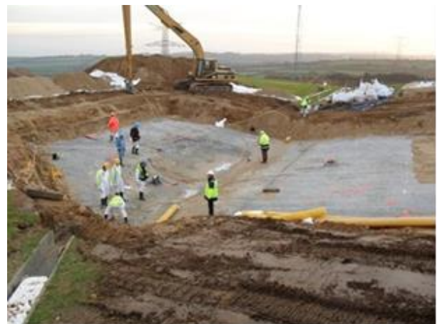
Figure 90. CSM de La Hague ; excavation de la zone de tassement différentiel (2011).
