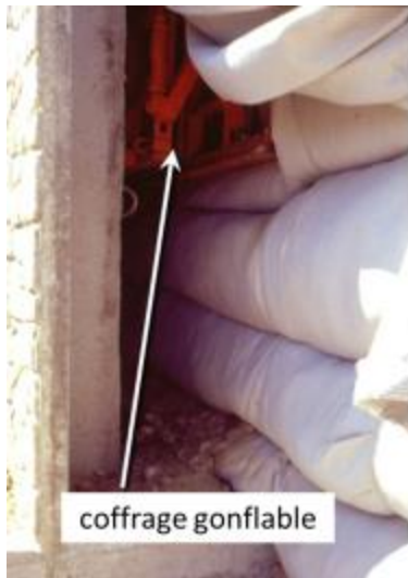
Figure 21. Un parement béton préfabriqué utilisé comme référence fixe supportant le coffrage gonflable.
