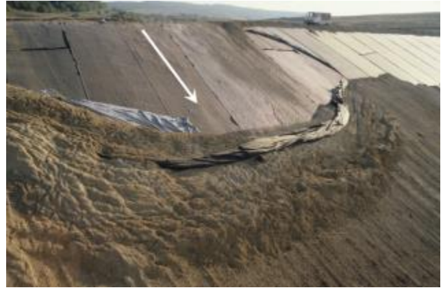
Figure 77. Barrage de l'Aubrac : vue rapprochée du glissement de la géomembrane et des couches de protection à l'interface avec le géotextile inférieur, pendant la construction (1986).
