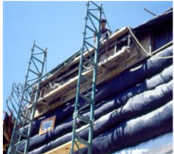
Figure 22. Vue des supports métalliques utilisés comme référence fixe et du coffrage gonflable en place sur la couche supérieure.
