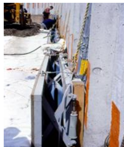
Figure 24. Les Hospices de France: coffrage gonflable s'appuyant sur le parement béton de référence pendant la construction.
