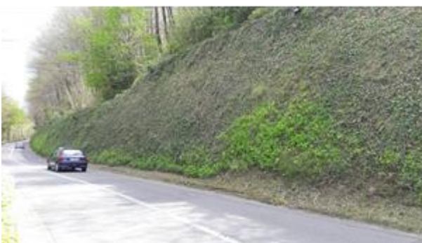
Figure 42. Gif sur Yvette ; vue du massif de soutènement micro-renforcé en 2016.
