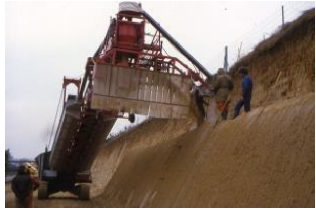
Figure 37. Mise en œuvre du micro-renforcement : les fils continus sont mélangés avec le sable.
