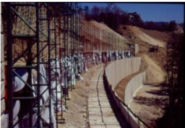
Figure 28. Autoroute Foix-Tarascon - MS13 : vue de la construction du 3 ème bloc supérieur avec les références fixes métalliques et les coffrages gonflables. Le parement béton définitif a déjà été mis en place pour les deux blocs inférieurs.
