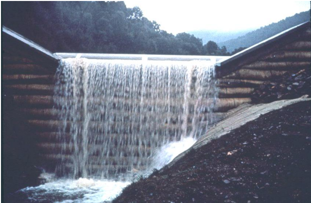
Figure 9. Vue du barrage de Maraval en service, peu après sa construction, en 1976.
