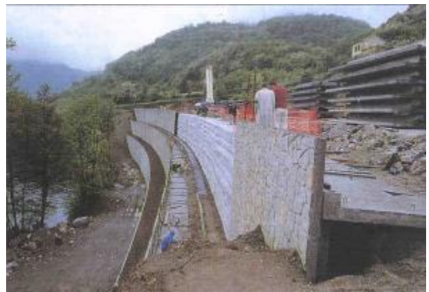
Figure 29. Autoroute Foix-Tarascon-MS13 : vue du 3 ème bloc renforcé finalisé, les références fixes ont été enlevées et le parement béton de protection est en cours de pose.
