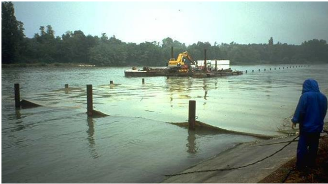
Figure 64. Canal de Jonage : installation du matelas géosynthétique en 1994.
