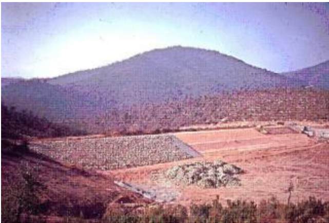
Figure 3. Vue du parement amont du barrage de Valcros pendant la construction en 1970
