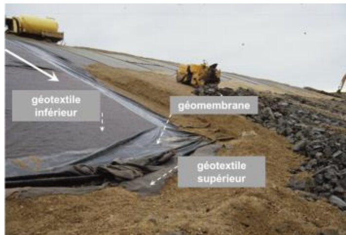
Figure 78. Barrage de l'Aubrac : vue détaillée du glissement à l'interface géotextile inférieur-géomembrane (1986).
