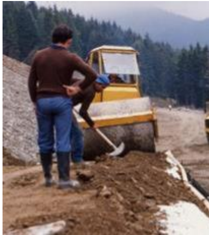
Figure 15. Vue de l'opération de compactage au voisinage du parement du massif de Prapoutel en 1982
