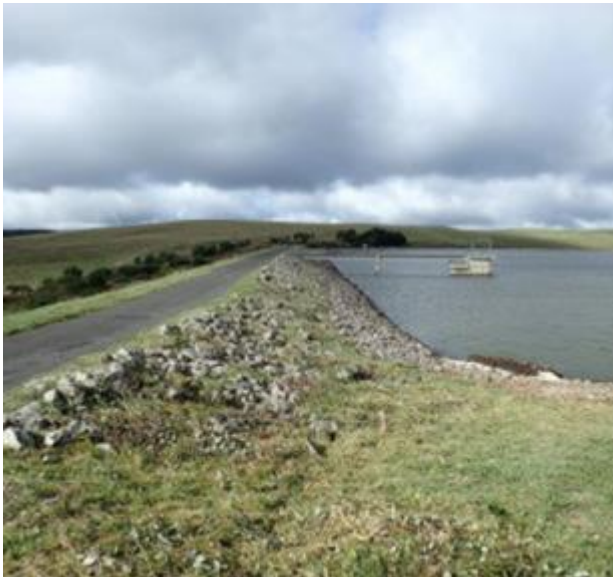
Figure 73. Barrage de l'Aubrac : vue de l'amont (2016).
