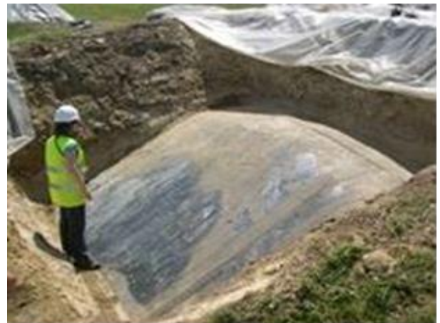
Figure 88. CSM de La Hague, glissement lent de la pente, 20 ans après construction. Excavation en crête.
