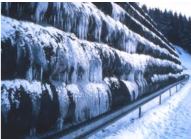
Figure 11. Vue du parement du massif de Prapoutel durant l'hiver 1998.
