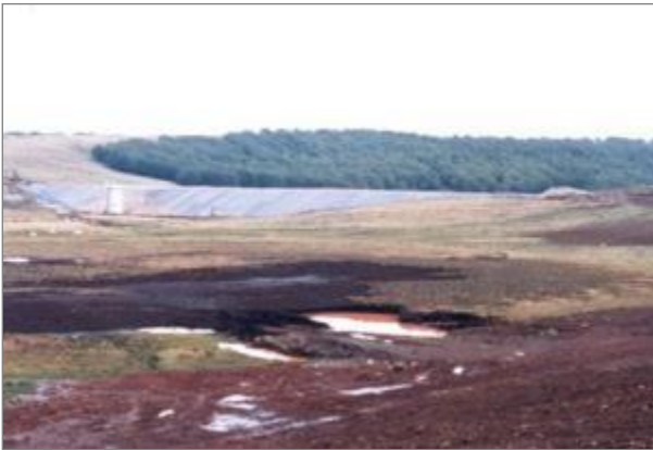
Figure 70. Barrage de l'Aubrac : géomembrane à nu pendant la construction (1986).
