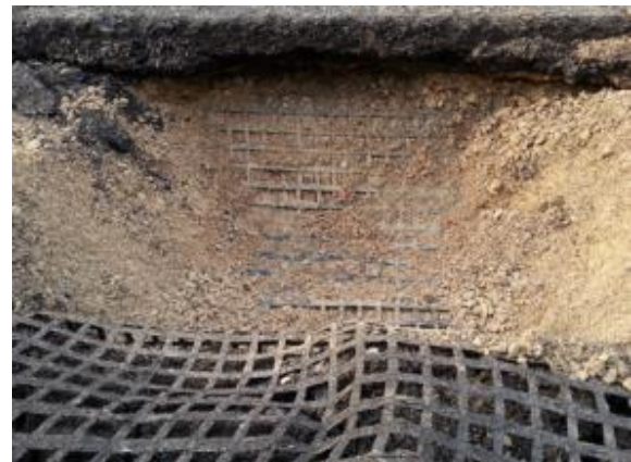
Figure 57. Trois Luc à La Valentine : décaissement jusqu'au géotextile dans la zone affaissée, en 2015.
