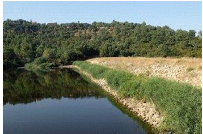
Figure 4. Vue du parement amont du barrage de Valcros en 2014
