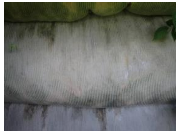
Figure 31. Autoroute Foix-Tarascon-MS13; vue rapprochée du géotextile au niveau de l'une des fenêtres de surveillance dans le parement béton , en pied du bloc inférieur (2016) ; quelques suintements au niveau des inter-couches, comme juste après construction.
