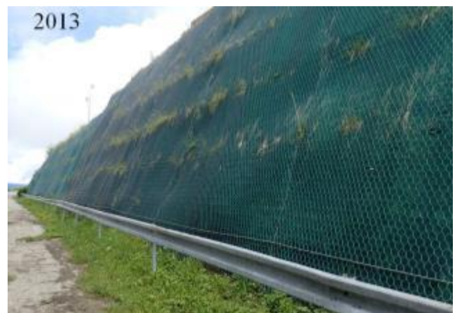
Figure 19. Vue du parement de Prapoutel en 2013.
