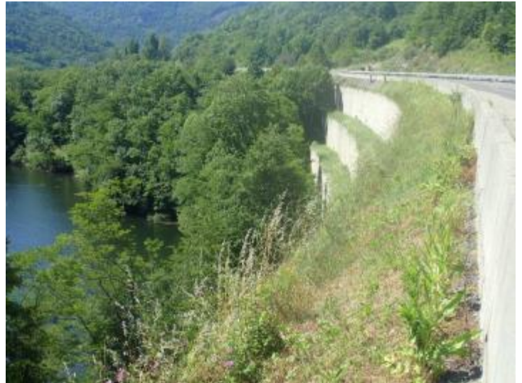
Figure 33. Autoroute Foix-Tarascon-MS13; vue Générale de l'autoroute et du massif renforcé (2016).
