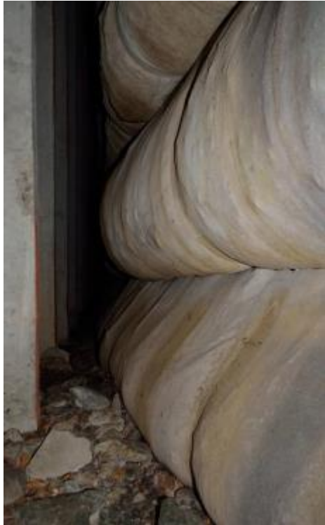
Figure 25. Les Hospices de France (2016) : vue du géotextile et de l'espace avec le parement béton
