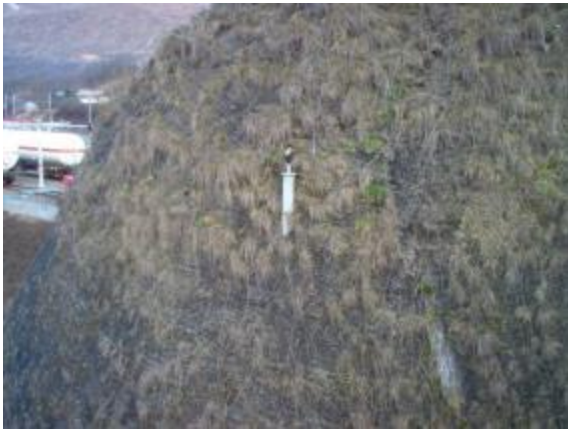
Figure 48. Frontenex : vue de détail de la surface du tumulus de sable micro-renforcé en 2016
