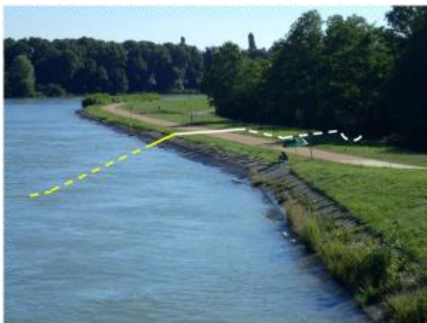
Figure 67. Canal de Jonage : vue globale de la digue aval au barrage et du matelas d'étanchéité en 2016 (en pointillés, le profil de la digue).
