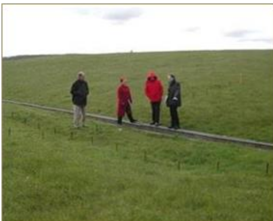
Figure 89. CSM de La Hague : localisation de la zone de tassement différentiel, avant excavation (2010).
