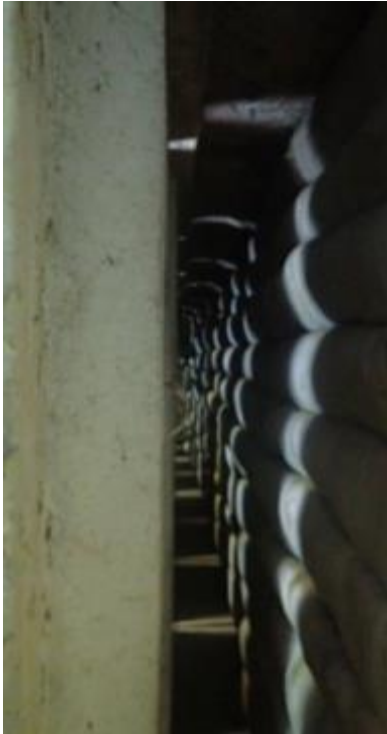
Figure 32. Autoroute Foix-Tarascon-MS13; vue de l'espace (~ 80 cm) entre le massif géosynthétique et le mur béton de protection, en pied d'ouvrage (2016).
