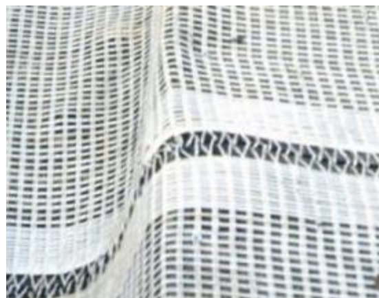
Figure 53. Trois Luc à La Valentine, vue de la liaison entre nappes de géotextile.
