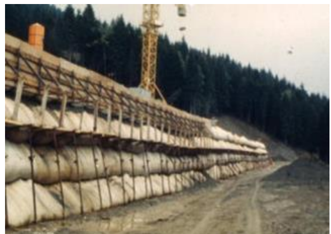
Figure 14. Vue des éléments de coffrage et du procédé de construction du massif de Prapoutel en 1982.
