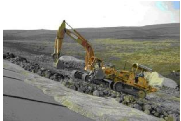
Figure 71. Barrage de l'Aubrac : mise en place de la protection en enrochement (1986).
