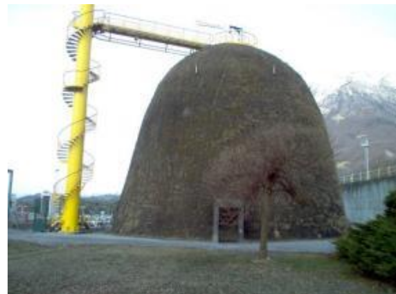
Figure 47. Frontenex : tumulus en sable micro-renforcé en 2016.
