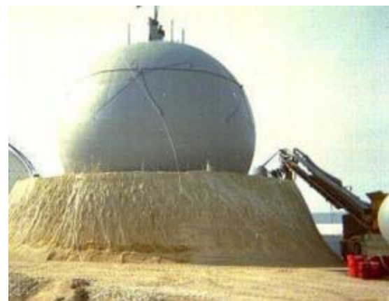
Figure 45. Vue de la couverture en sable micro-renforcé pendant sa construction.
