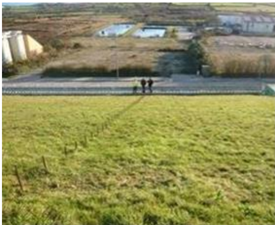
Figure 87. CSM de La Hague, glissement lent de la pente, 20 ans après construction.
