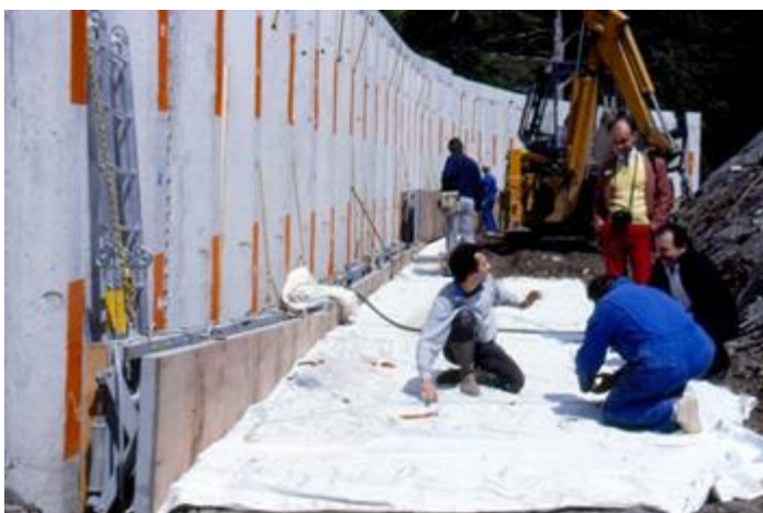
Figure 23. Les Hospices de France : phase de construction avec pose des capteurs de déformation sur le géotextile.
