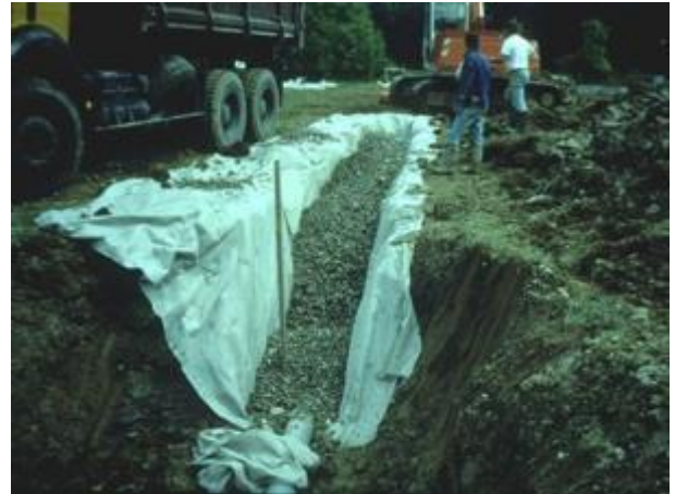
Figure 59. Vue d'une tranchée drainante en construction, avec le drain collecteur de fond, le gravier et le filtre géotextile.
