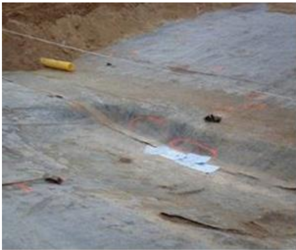
Figure 91. CSM de La Hague : excavation de la zone de tassement différentiel ; géomembrane pontant la zone d'effondrement (2011).
