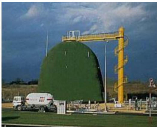
Figure 46. Frontenex: tumulus en sable micro-renforcé juste après construction en 1992.
